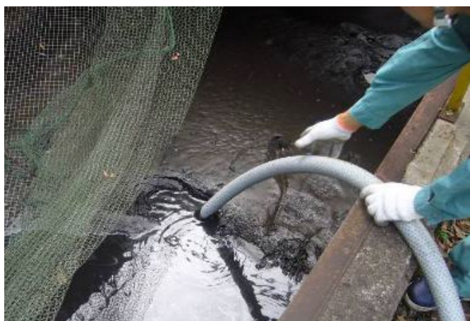
引き抜き状況
