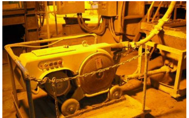
スクイズポンプ設置状況
