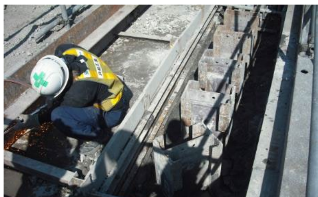
H鋼の周りにモルタルを流し込む
