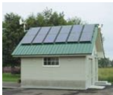
▲ 太陽電池発電システム
